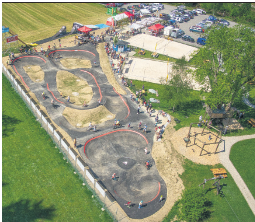
Eine mächtige Anlage wartet nun bei Forum Sumiswald darauf, mit verschiedensten Geräten befahren zu werden.
